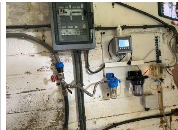
Fotografia 23. Analitzador-dosificador de clor en continu
