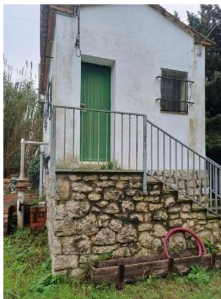
Fotografia 16. Exterior caseta i antics calderons
