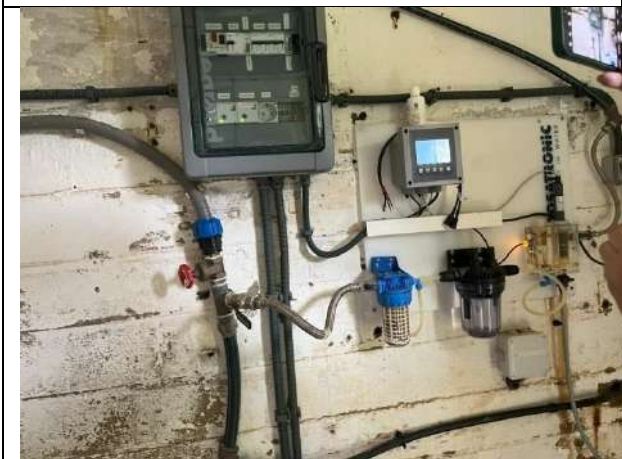
Fotografia 23. Analitzador-dosificador de clor en continu
