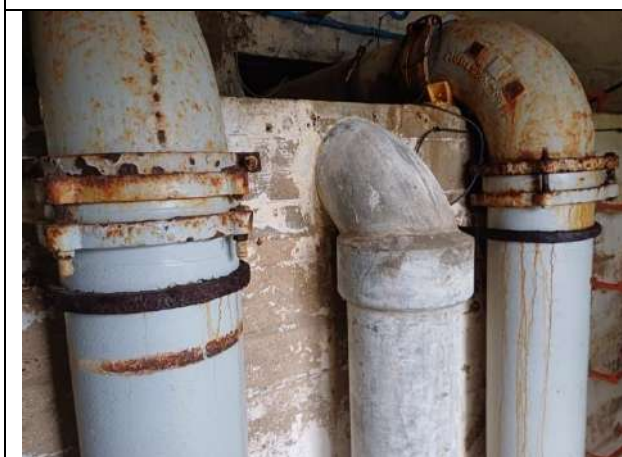
Fotografia 21. Conduccions entrada i sobreexidor
