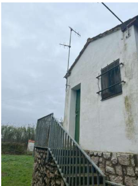
Fotografia 9. Vista exterior caseta de control
