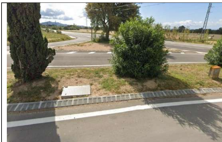
Fotografia 37. Arqueta conducció a Pau
