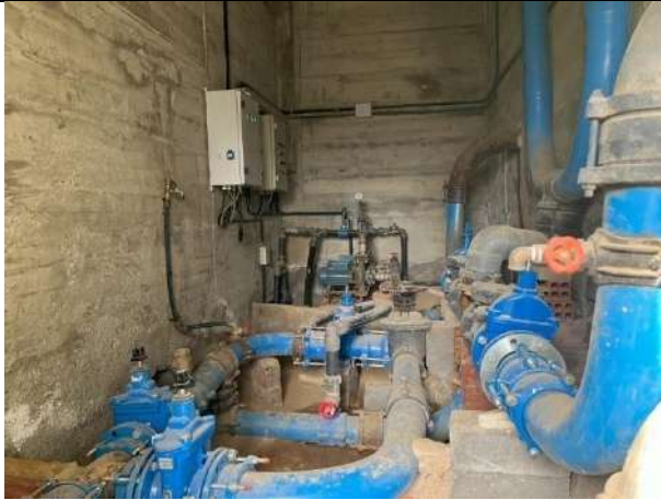
Fotografia 54. Caldereria conduccions entrada i sortida
