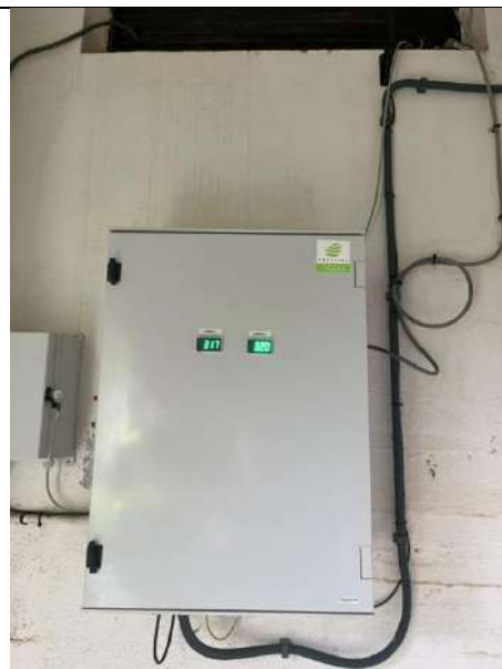
Fotografia 26. Remota de control. Visor nivells
