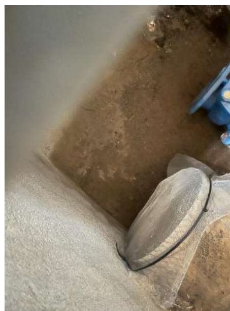
Fotografia 93. Buidat i sobreeixidor
