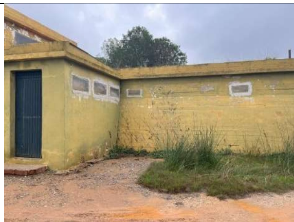
Fotografia 18. Ventilacions laterals del dipòsit
