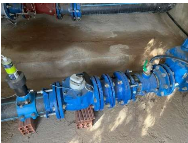
Fotografia 64. Cabalímetre i analitzador de clor
