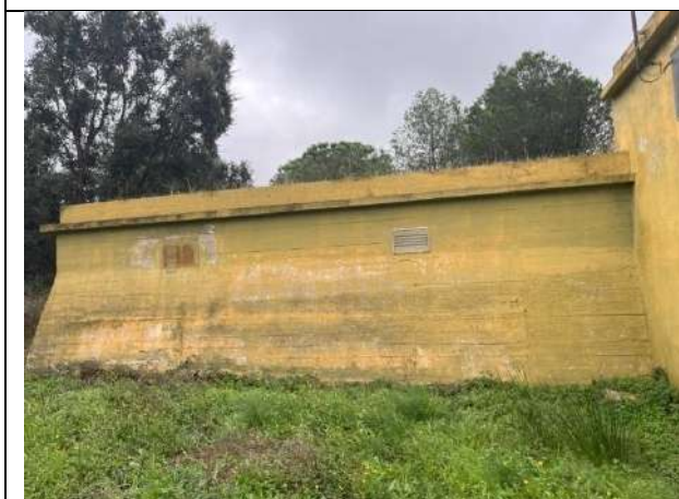
Fotografia 19. Ventilacions laterals del dipòsit
