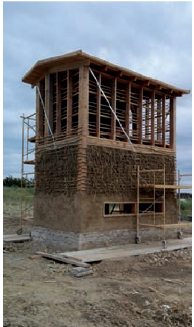
Estructura de la torre
