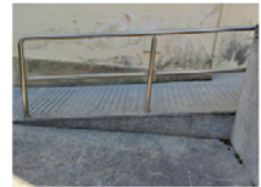
Foto 3: Rampa accés a l'edifici
