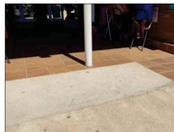
Foto 5: Pla inclinat en la zona d'accés
