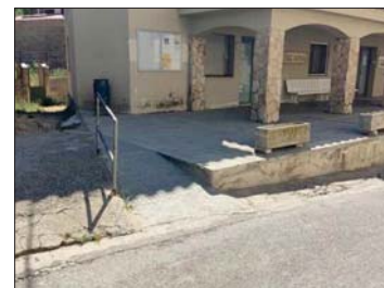
Foto 1: Rampla en l'accés
