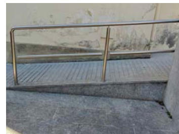
Foto 3: Rampa accés a l'edifici
