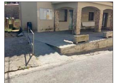
Foto 1: Rampa en l'accés
