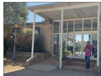
Foto 1: Accés a la piscina
