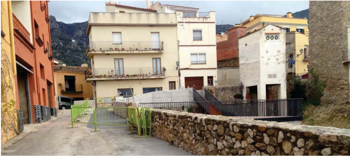
Vista del carrer de la Pujada amb els murets de formigó executats
