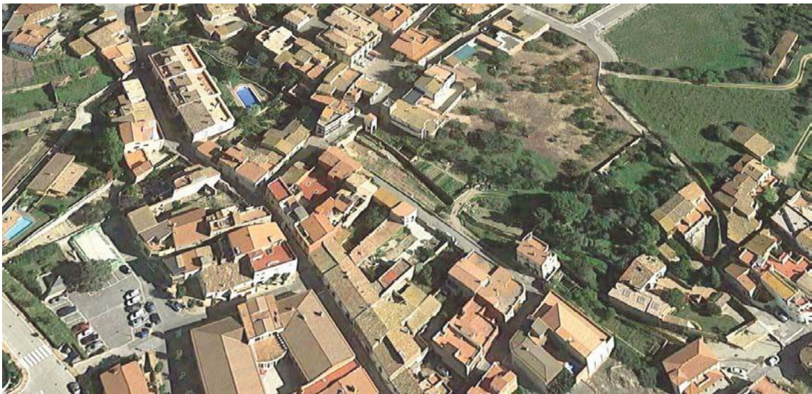
Imatge de l'àmbit amb Can Lluent enderrocat i les obres de l'equipament pendents d'executar
