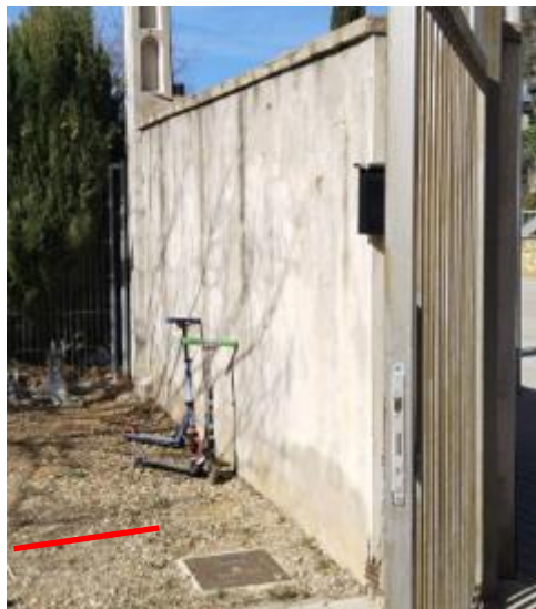
Il·lustració 13 - Canalització soterrada fins al comptador
